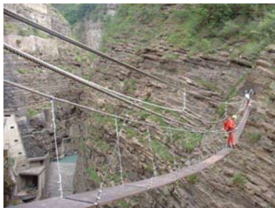
Via ferrata du Sautet Longueur = 45 m Largeur du platelage = 0.70 m
