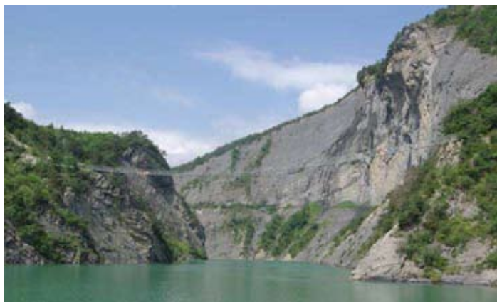
Passerelle du Monteynard Longueur = 200 m Largeur du platelage = 1.50m
